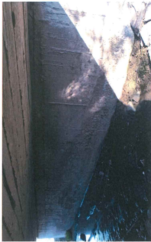
Obrus opěr a NK , sanace opěr + NK a vyčištění území pod mostem.
